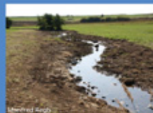
Herstellung eines geschwungenen Bachbettes Herstel van de slingerende beekloop Constructing a meandering course for the
