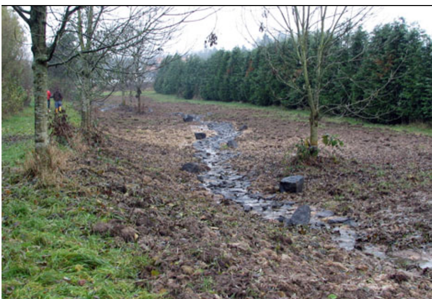
Renaturierung Wingels- bach / Horngraben (2. Bauabschnitt 2012 / 2013), Höhe Angelweiher
