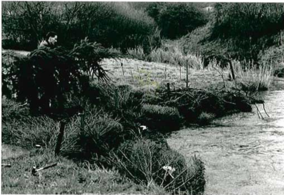
Abbildung 9: Ufersicherungs-Maßnahmen durch Einbringung von Raubbäumen oberhalb der Mönbach-Kolonie am 22. Februar 1989
