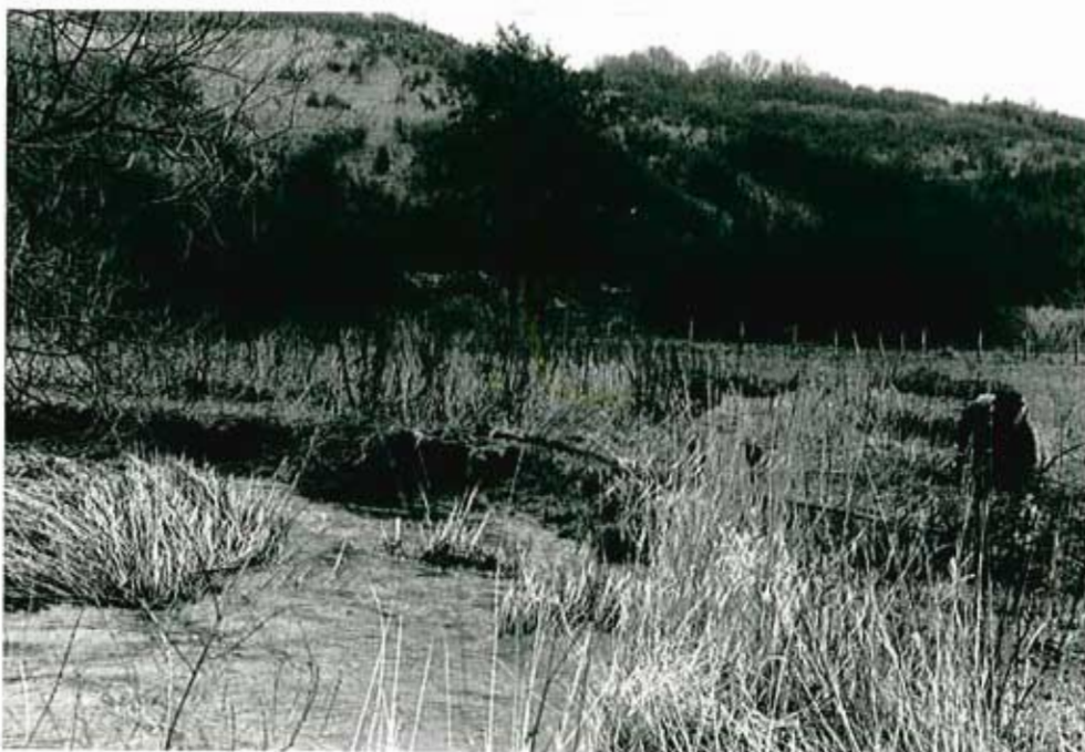
Abbildung 10: Ufersicherungs-Maßnahmen durch Einbringung von Raubbäumen oberhalb der Bierbach-Kolonie am 22. Februar 1989
