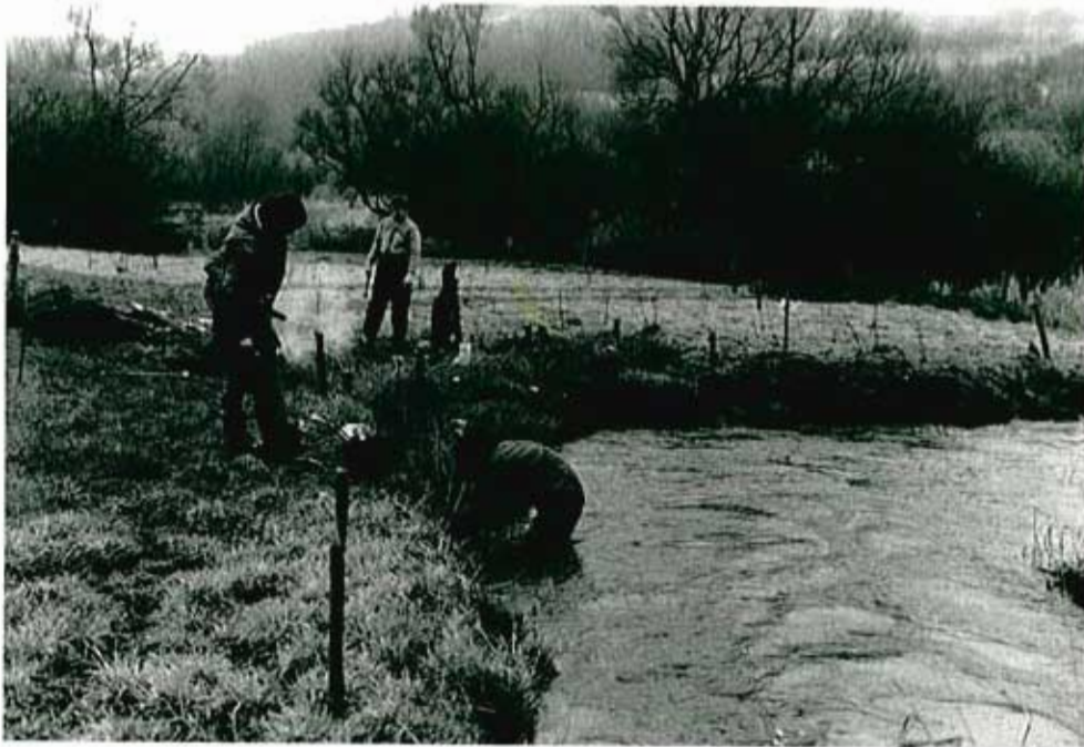
Abbildung 7: Ufersicherungs-Maßnahmen durch Einbringung von Raubbäumen oberhalb der Mönbach-Kolonie am 22. Februar 1989
