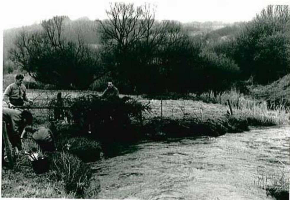
Abbildung 8: Ufersicherungsmaßnahmen wie oben (Abbildung 7)
