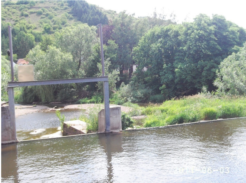
Abb. 3: Blick ins Unterwasser der Banmühle, Odernheim
