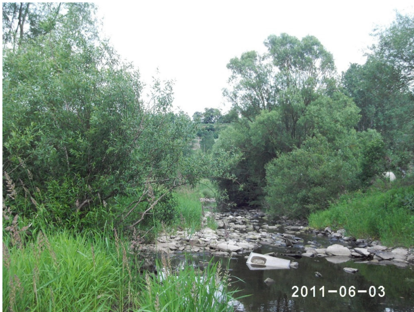
Abb. 6: Unterwasserbereich des Wehres Niedermühle, Odernheim
