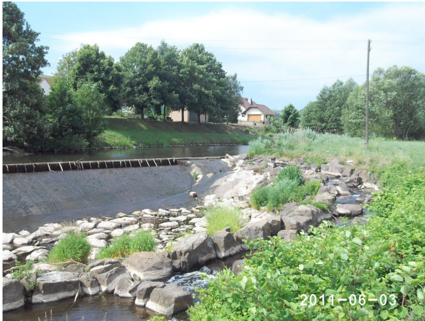
Abb. 7: Wehr in Höhe der Ortslage Rehborn
