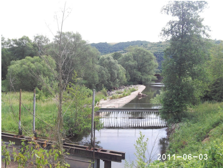
Abb. 5: Wehr flussaufwärts der Niedermühle, Odernheim
