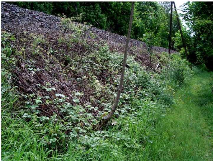
Abb. 9: Im Bahndamm oberhalb des Wehres liegen Winterquartiere der Würfelnatter.
