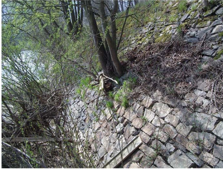
Abb. 14: Mauer zum Schleusenkanal, die von der Würfelnatter am Überwinterungs- und Sonnenplatz genutzt wird
