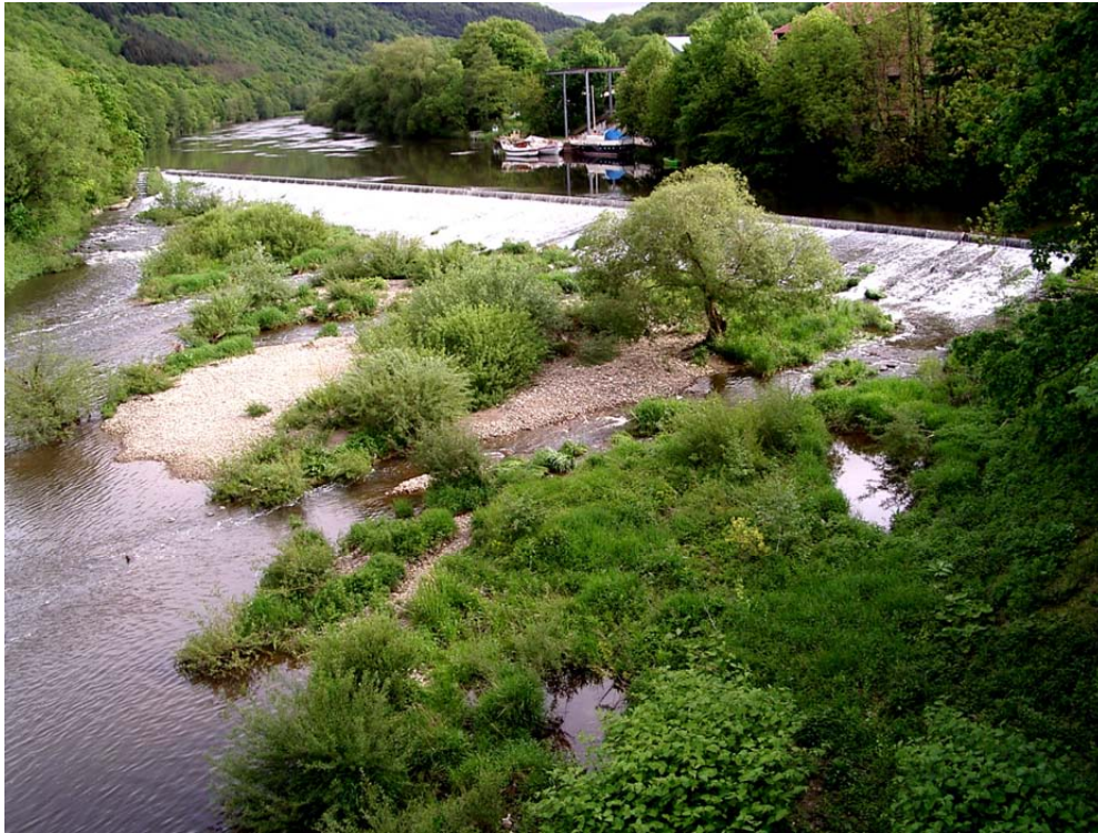
Abb. 4: Geschiebeinseln im Unterwasser des Wehres Friedrichsegen
